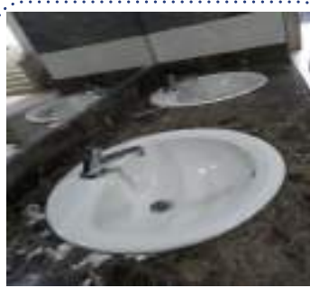
Figura 9.1: Consumo de agua, baños
