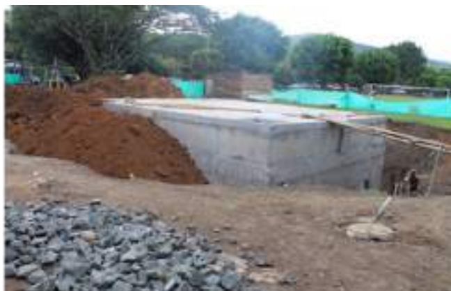
Tanques de recolección de aguas lluvia
